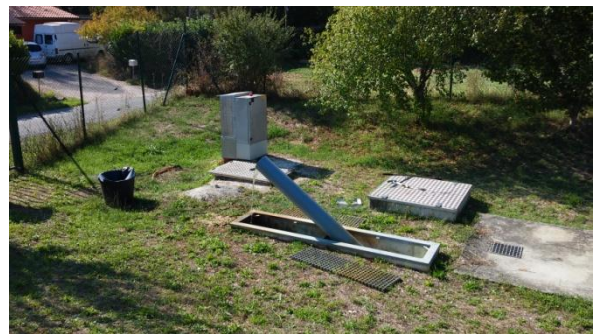
Vue du dispositif de sortie d'eau de la station.
