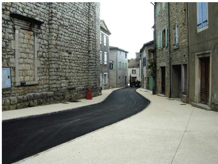
Exemple d'enrobé noir classique et trottoir surélevé en béton désactivé
