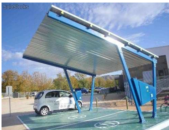
Toiture solaire pour recharge des bornes
