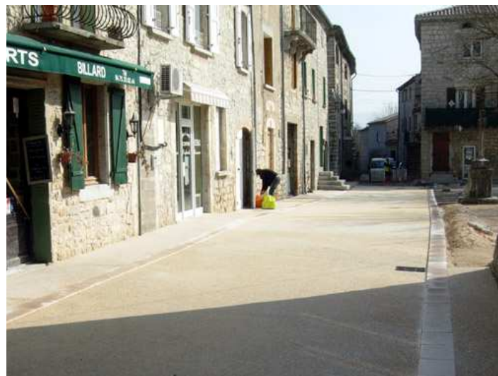
Exemple d'enrobé grenailé clair et trottoir à niveau en béton désactivé
