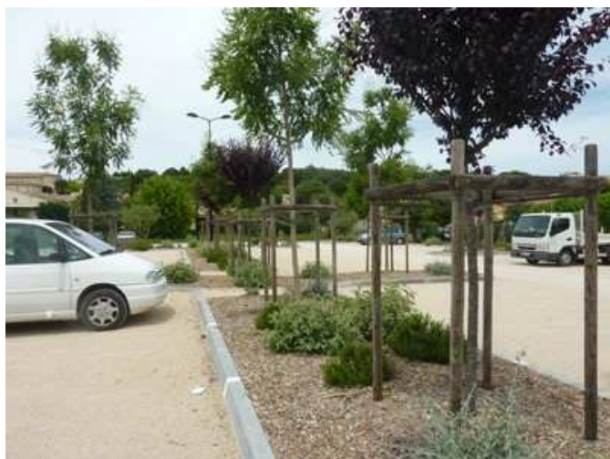
Parking paysager : voie et emplacements en stabilisé avec plantations, bordure béton
