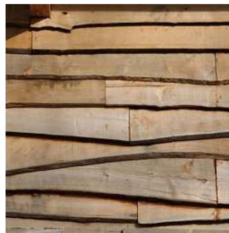
Bardage horizontal irrégulier
