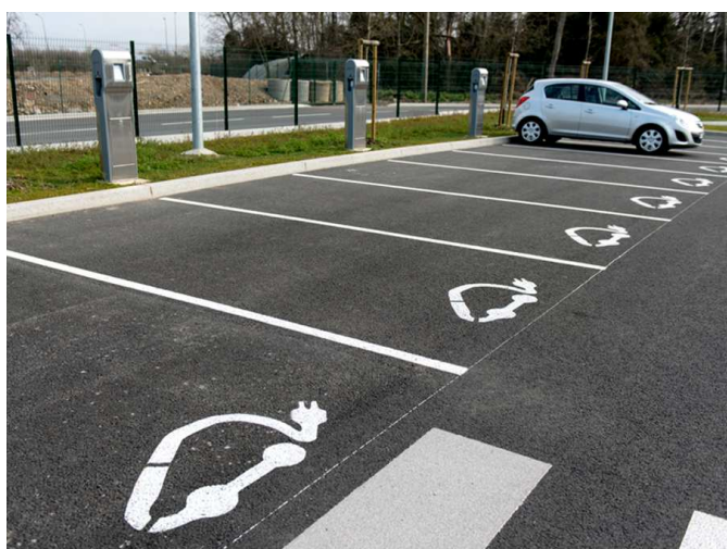
Parking extérieur simple avec borne et marquage peinture
