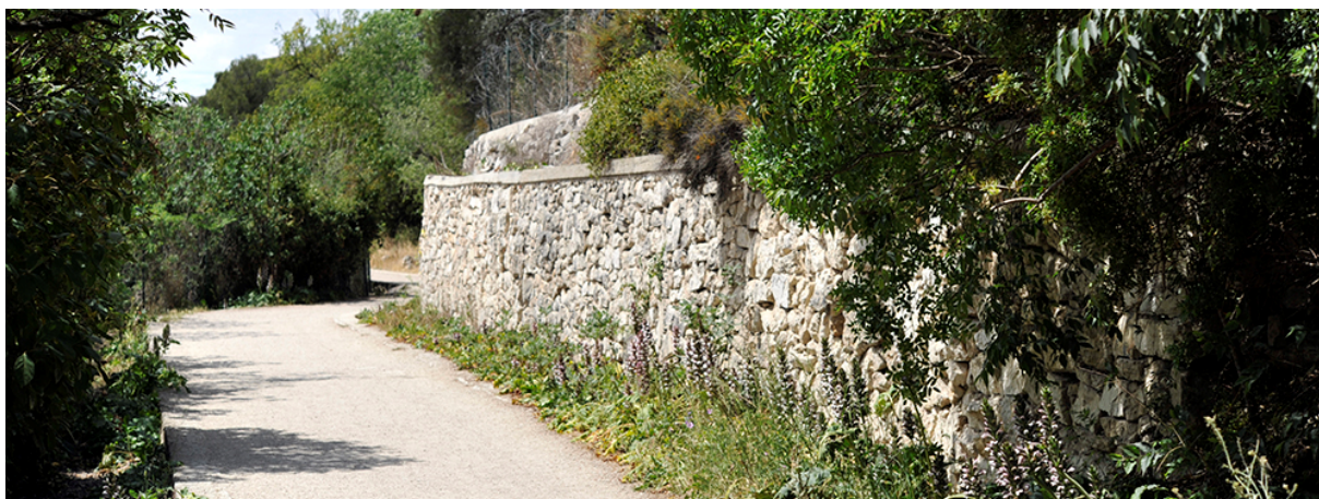
Exemple de voie aménagée avec végétalisation en pied de muret
