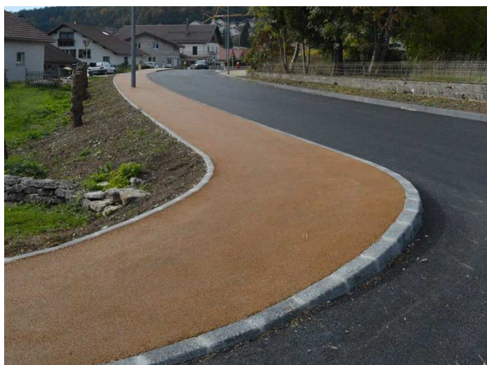
Exemple de bordure en béton
