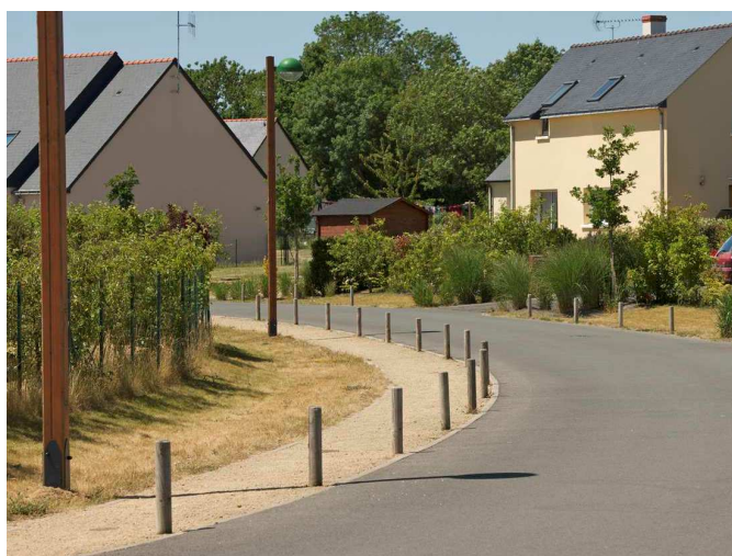
Ambiance rue jardinée avec potelets séparatifs, accotements piétons en stabilisé et bande engazonnée en creux formant noue
